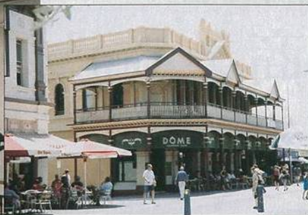
オーストラリア・フリーマントル市では、150～100年前の歴史的建造物がカフェ、病院、オフィスなどに改造されている。写真の「DOME」は、「エコロジー」をテーマにオーストラリアやアジアで店舗展開するカフェ
